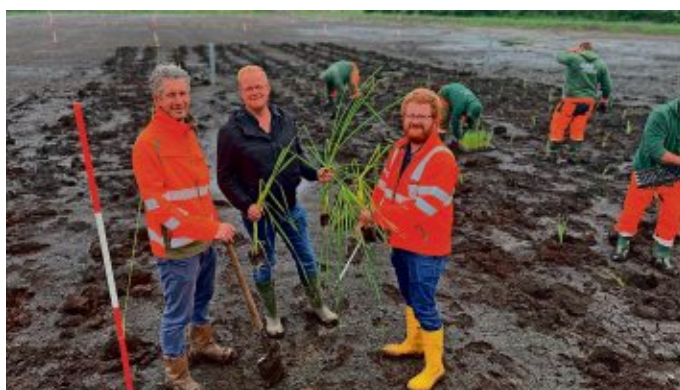
Waren live dabei, als die ersten Pflanzen in die Erde kamen (von links): Jonas de Vries, Bauleiter bei der Firma Schlichtmann, Tjade Handke von der Stadt Geestland und David Harms vom Ingenieurbüro IGB. Foto: Stadt Geestland
