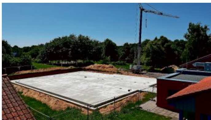
Im Mai wurde die Bodenplatte für die neue Mensa gegossen.
