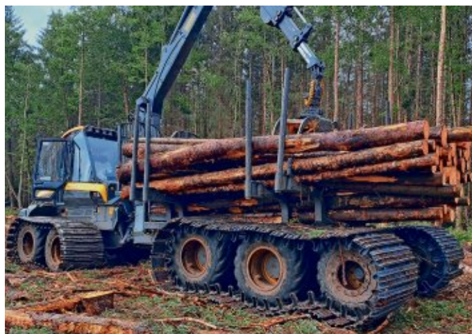
Erntemaschine und Rückeschlepper fahren mit Bändern, um den Bodendruck zu minimieren. Bei Bedarf werden zusätzlich noch mobile Baggermatten untergelegt.
